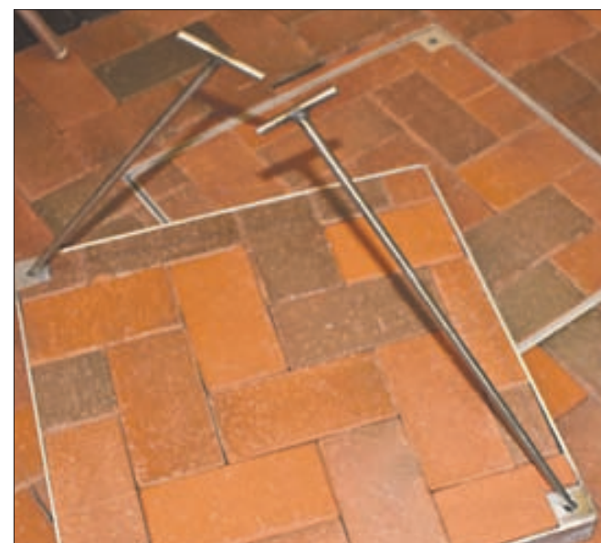
Dækslet håndteres af to løftestænger. Til de større modeller har producenten Jesmig Group ApS en løftevogn undervejs.
